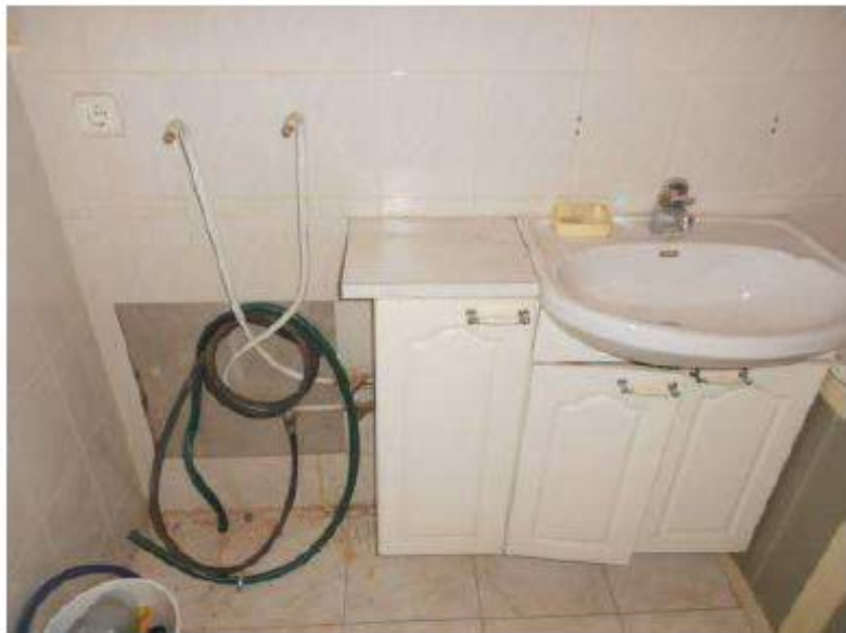
Фото 29. Ванная (помещение №5 по БТИ)
