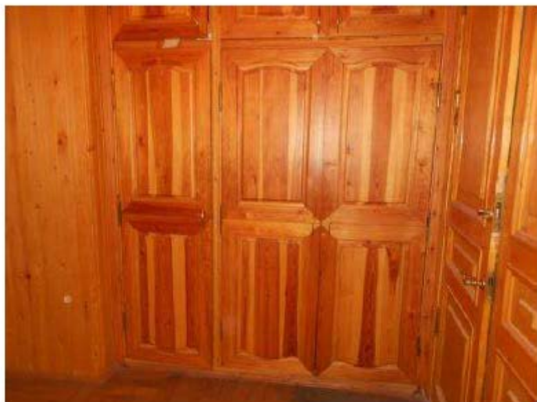
Фото 39. Коридор (помещение №6 по БТИ), кладовые (помещения №9 и 8 по БТИ)
